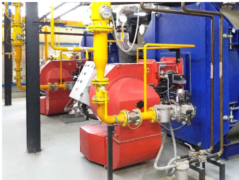
Блочно-модульная котельная, г. Грозный, горелки: Multicalor 800.1 PR TC и Multicalor 600.1 PR TC.
