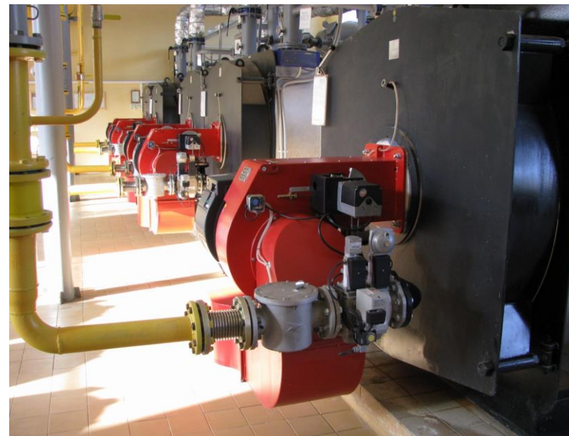
Производственная котельная, республика Мордовия, котлы Esotax NC 4000-N и горелки BLU 6000.1 PR TL.
