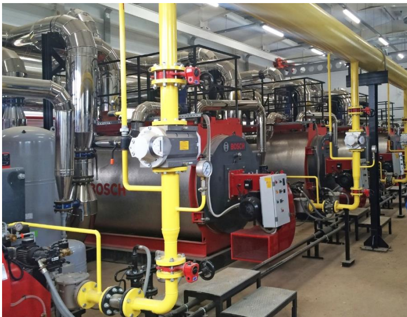
Блочно-модульная котельная, Московская область, горелка Multicalor 600.1 PR TL.
