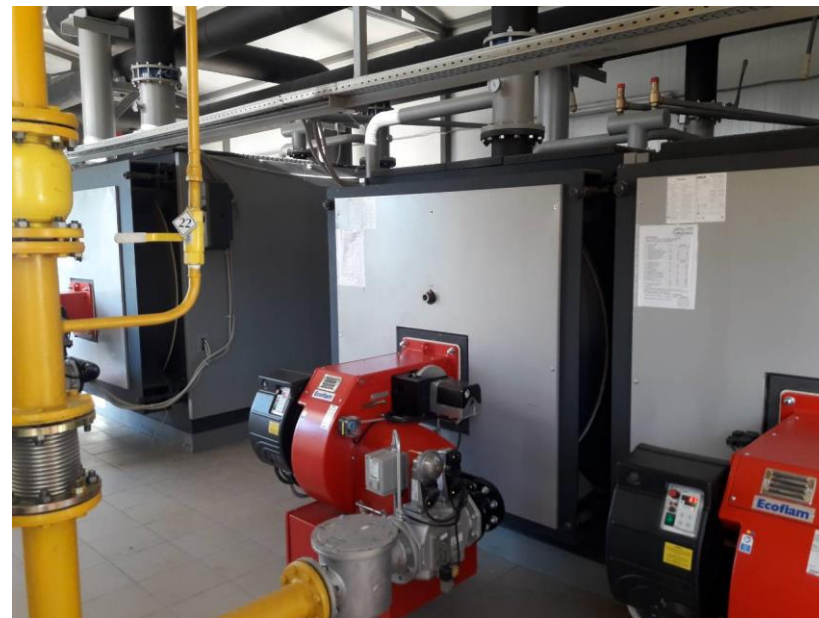
Котельная, г. Саранск, котлы Ecomax NC4000-N и горелки BLU 6000.1 PR TL.
