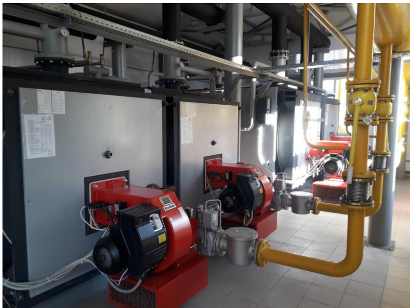
Котельная, г. Саранск, котлы Ecomax NC4000-N и горелки BLU 6000.1 PR TL.
